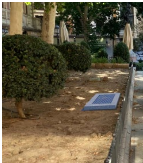
Figura nº 46: Creación de rejilla de ventilación en parterre (antes / después)
